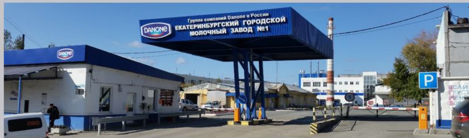
ОАО «ЕКАТЕРИНБУРГСКИЙ ГОРОДСКОЙ МОЛОЧНЫЙ ЗАВОД №1» УСИЛЕНИЕ МЕТОДОМ ТОРКРЕТИРОВАНИЯ БЕТОНА
