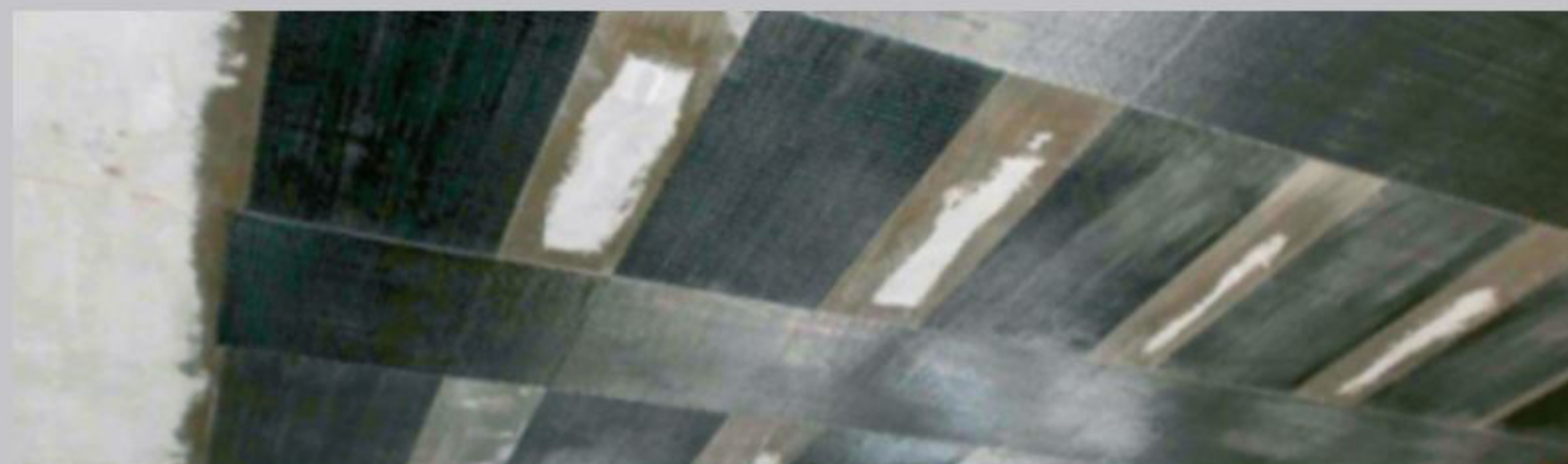
УСИЛЕНИЕ ПЕРЕКРЫТИЯ И ПИЛОНОВ ЗДАНИЯ
