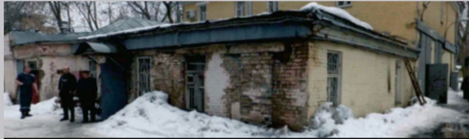
РЕМОНТ И УСИЛЕНИЕ НАРУЖНОЙ СТЕНЫ КИРПИЧНОГО ЗДАНИЯ
