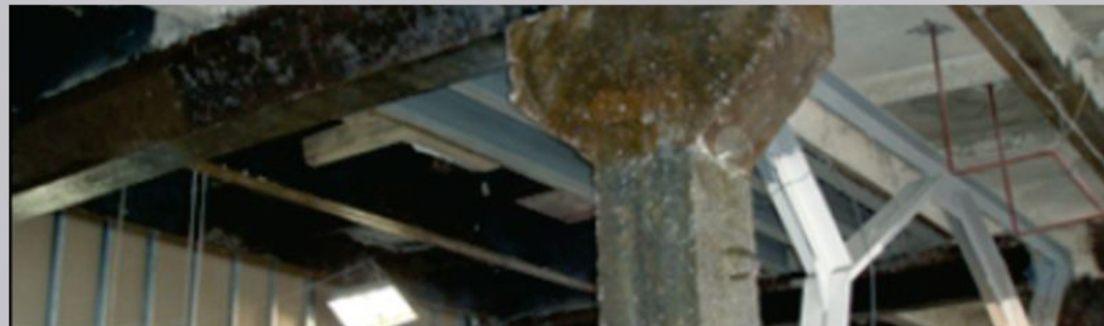
РЕКОНСТРУКЦИЯ ЖИЛОГО ДОМА
