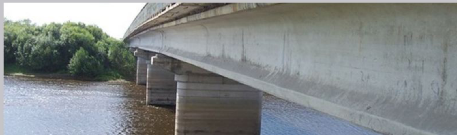
РЕМОНТ ЖЕЛЕЗОБЕТОНОГО МОСТА
