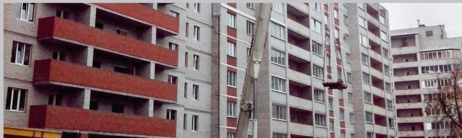
УСИЛЕНИЕ ПЛИТ ПОКРЫТИЯ В МНОГOKВАРТИРНОМ ЖИЛОМ ДОМЕ Г. ИЖЕВСК
