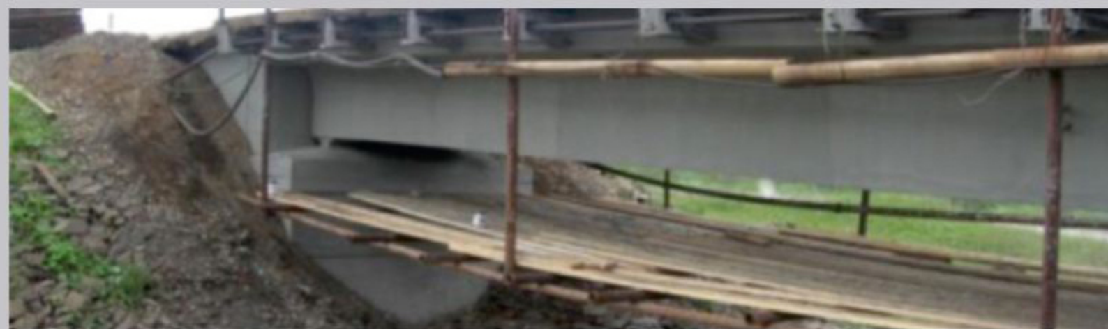
ЖЕЛЕЗНОДОРОЖНЫЙ МОСТ Г. СОЛИКАМСК
