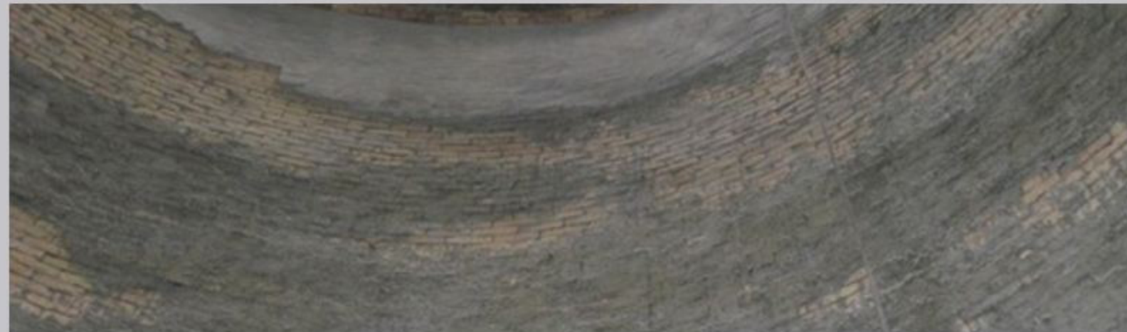
ВОССТАНОВЛЕНИЕ ЗАЩИТНОГО СЛОЯ ЖЕЛЕЗОБЕТОНА
