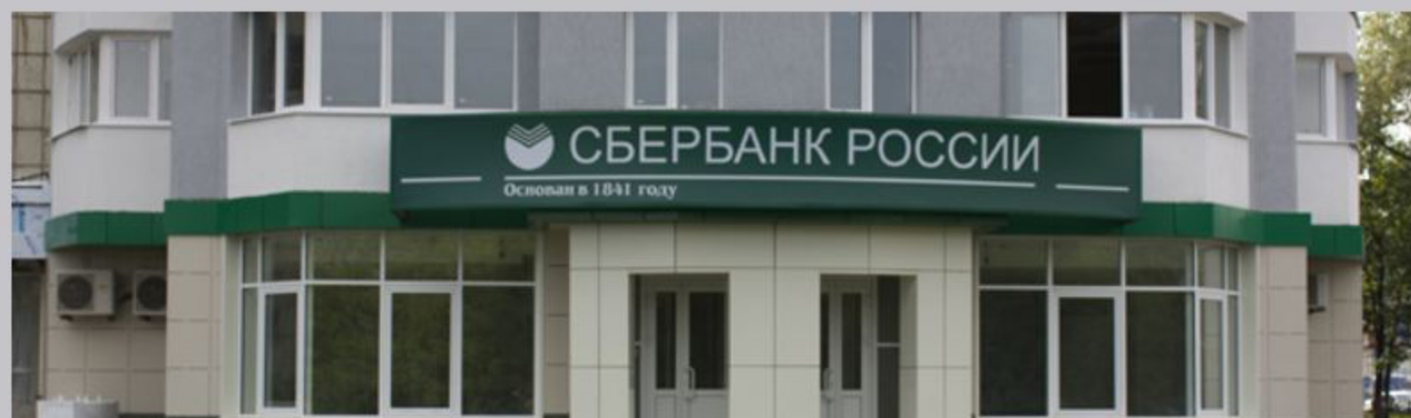
УСИЛЕНИЕ Ж\Б ПЛИТ ПЕРЕКРЫТИЯ ДЛЯ НУЖД "СБЕРБАНКА" Г.КРАСНОЯРСК, НОЯБРЬ 2014Г.
