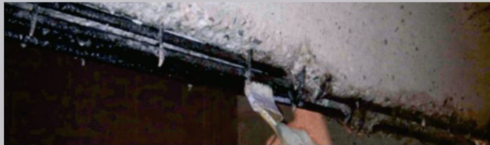
ТЕПЛОВОЙ ЦЕНТРАЛЬНЫЙ ПУНКТ, ОБСЛУЖИВАЮЩИЙ 6 МНОГОЭТАЖНЫХ ДОМОВ, СРОК ЭКСПЛУАТАЦИИ 45 ЛЕТ.
